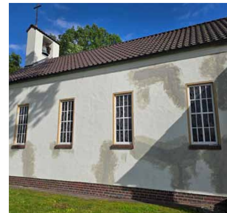
Ausbesserungsarbeiten an der Fassade
